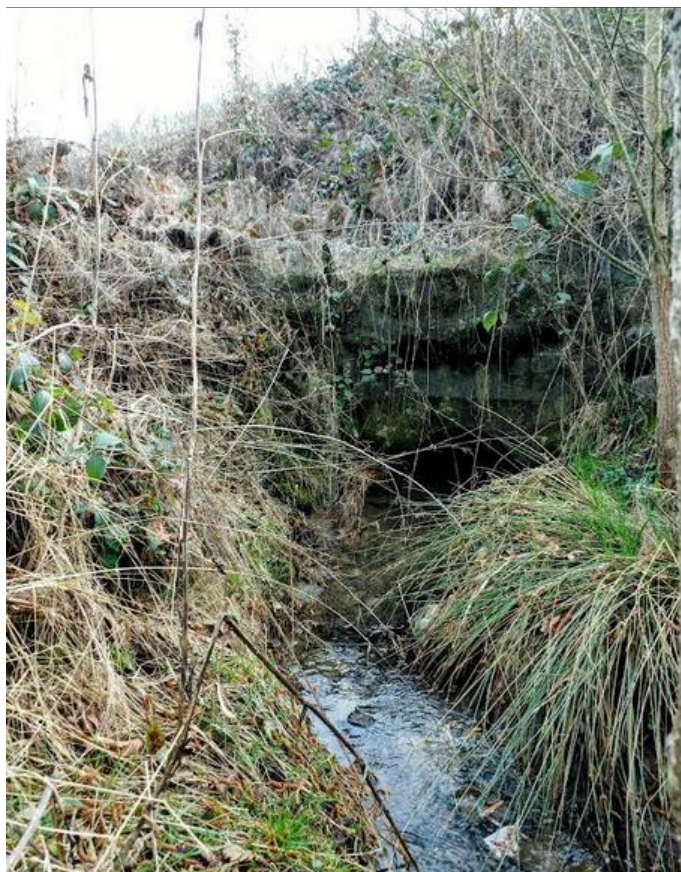
Figure 1 Emissaire au pied du remblai de l'autoroute
